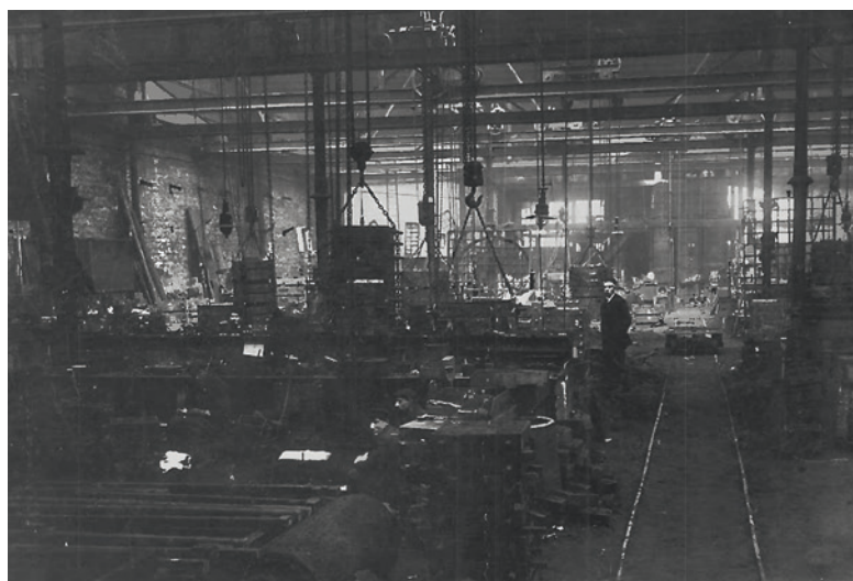
Photo d'époque de l'ancien site. Seules les poutrelles ont été conservées.
