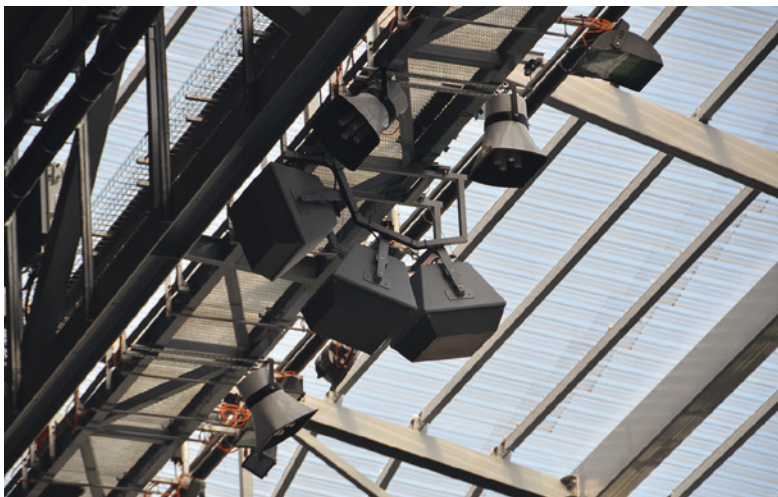
La sonorisation de stade nécessite des moyens lourds. Ici EAW en sonorisation et projecteur de son en sécurité. © Axente
