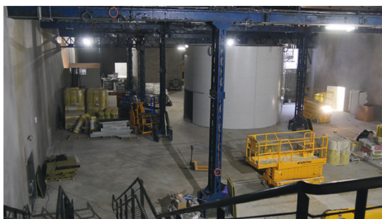
Vue du chantier (depuis la mezzanine). Les travaux sont colossaux avec entre autre la construction d'une citerne qui sera de surface de projection (intérieur et extérieur).
