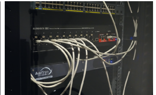
Baie technique avec patch RJ-45 pour le monitoring casque et plate-forme Auvitrans Audiotoolbox AVBX3. © B Stefani
