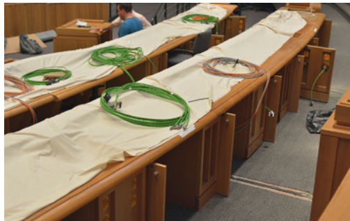
Recablage en salle.
