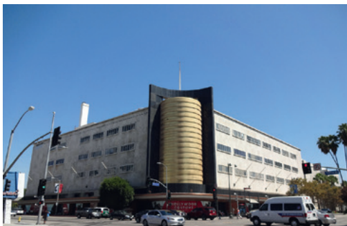
Le bâtiment du musée avant rénovation.
