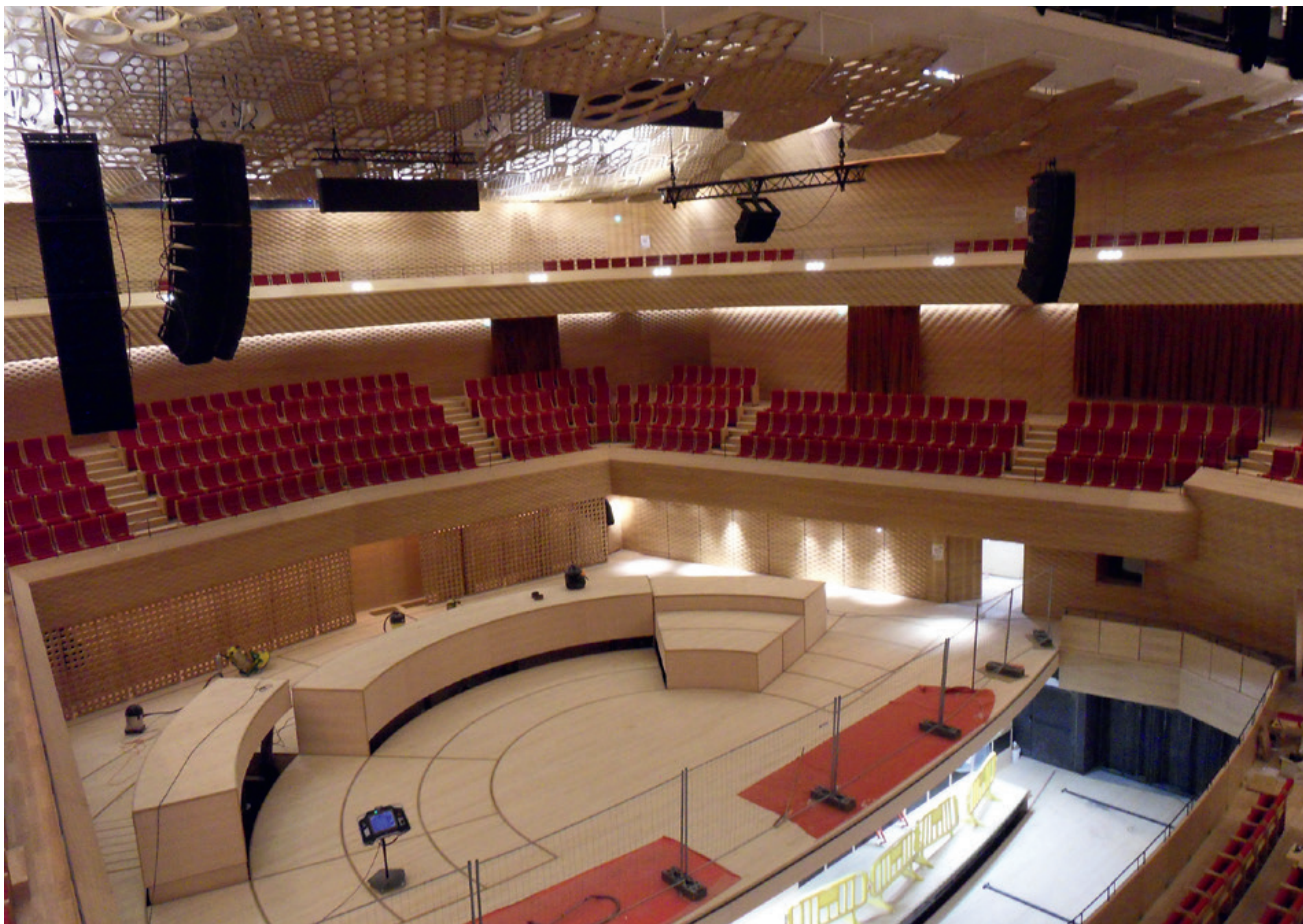
Videlio a développé le réseau interne de la Seine Musicale de l'île Seguin, en région parisienne. Une régie centrale communique avec l'ensemble des salles, comme ici l'auditorium.
